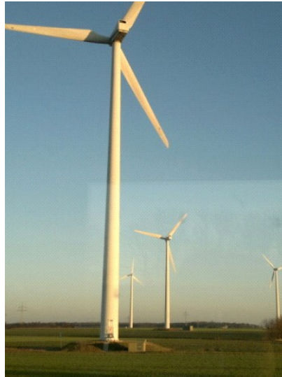
Fotografia 1. Elektrownia wiatrowa. Źródło: własny zbiór
